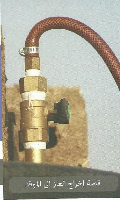
فتحة إخراج الغاز الممزوج بالمواد الصلبة الأخرى
